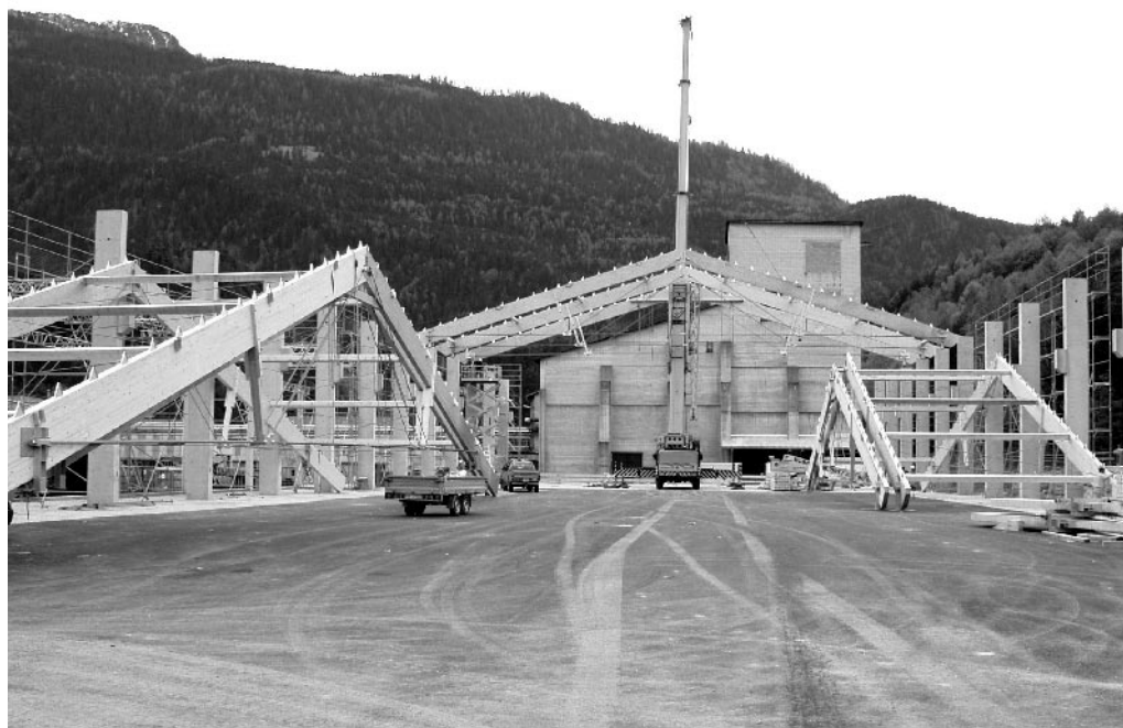
Tegra in der Bauphase.
